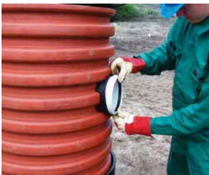
4. W przypadku trudności z montażem krawędzie otworu można posmarować środkiem poślizgowym.
