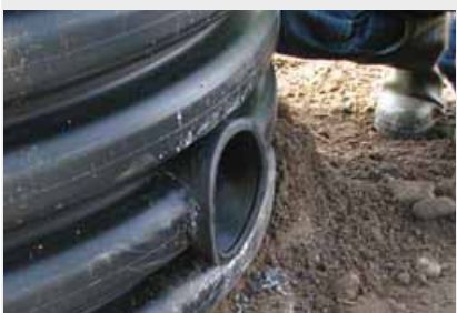
4. W przypadku trudności z montażem krawędzie otworu można posmarować środkiem poślizgowym.
