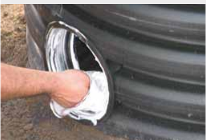
1. Specjalną wyrzynarką wykonuje się otwór w rurze karbowanej.
