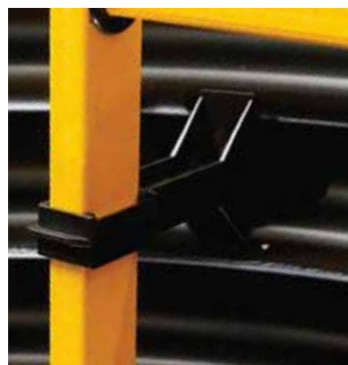
Rys. 6. Zamontowanie zaślepek przy wspornikach
