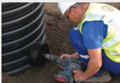
2. Następnie oczyszcza się krawędzie otworu z zadziorów.
