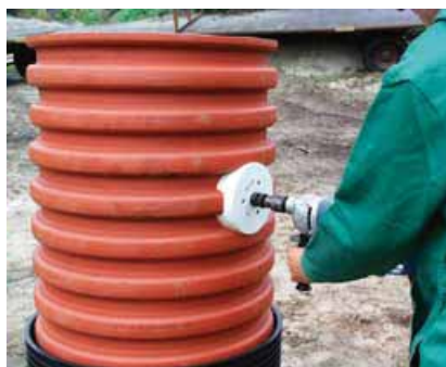
1. Specjalną wyrzynarką wykonuje się otwór w rurze karbowanej.
