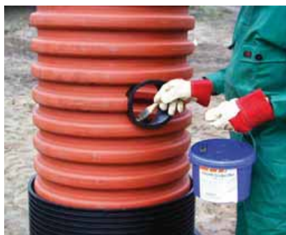
2. Następnie oczyszcza się krawędzie otworu z zadziorów.
