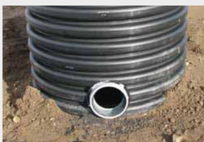
5. Wnętrze zamontowanej uszczelki smaruje się środkiem poślizgowym, co pozwala na zamocowanie w niej kształtki kielichowej.
