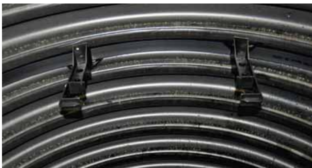
Rys. 5. Premontaż obejmy drabinki w rurze trzonowej
